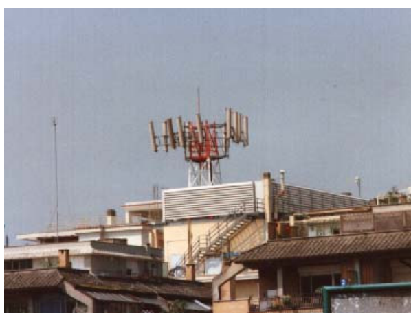
Ripetitore per telefonia cellulare 900 e 1800 Mhz
